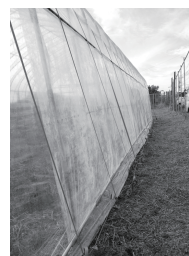
巻き上げパイプ取り付け
