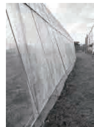
巻き上げパイプ取り付け
